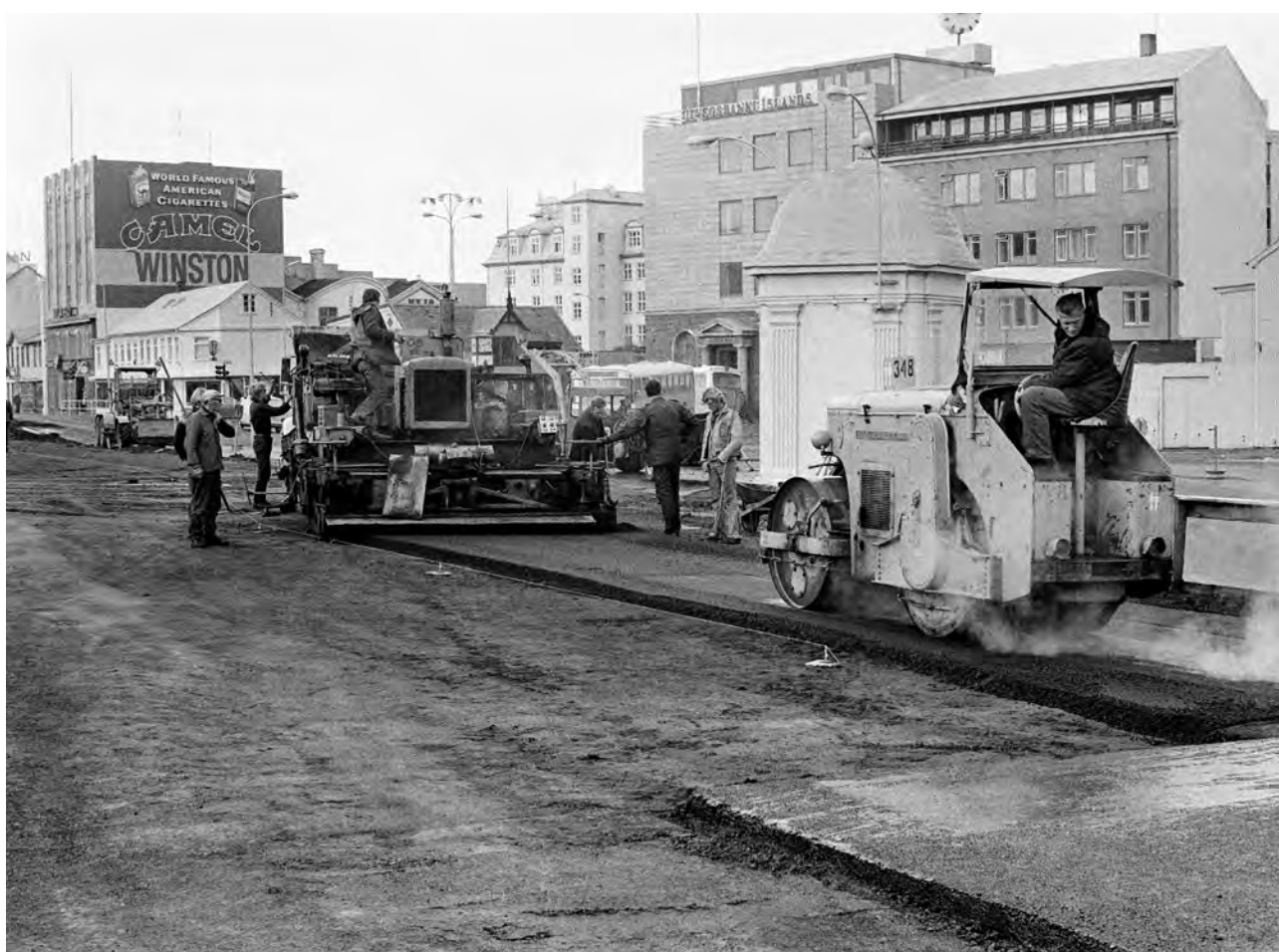
Unnið að breikkun Lækjargötu í Reykjavík í september 1971. Ljósmynd: Ljósmyndasafn Reykjavíkur / Vísir
